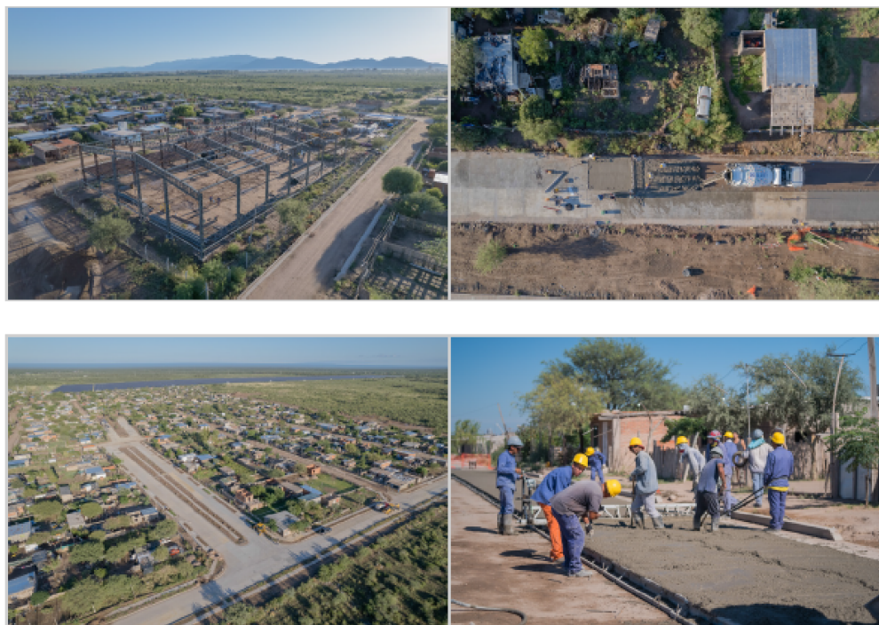
Figura 2: Avance de las obras en el barrio República
